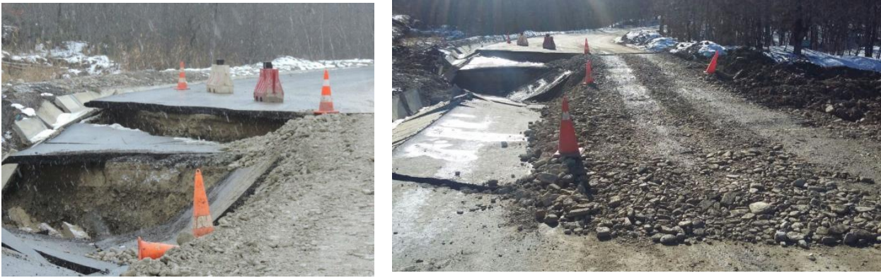
Şəkil 3. Xızı-Altıağac avtomobil yolunda baş vermiş sürüşmə
